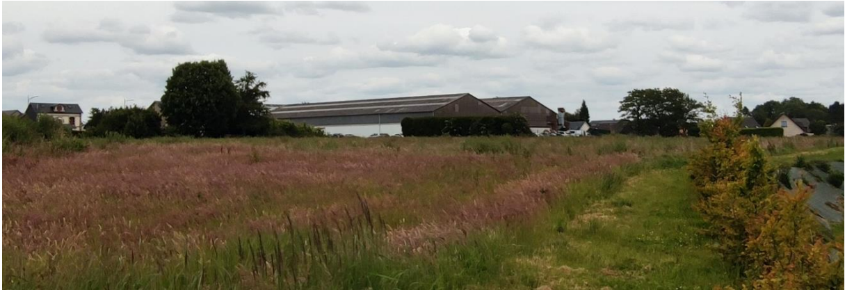
Photographie 3 : Vue depuis l'espace de stationnement de la zone commerciale
